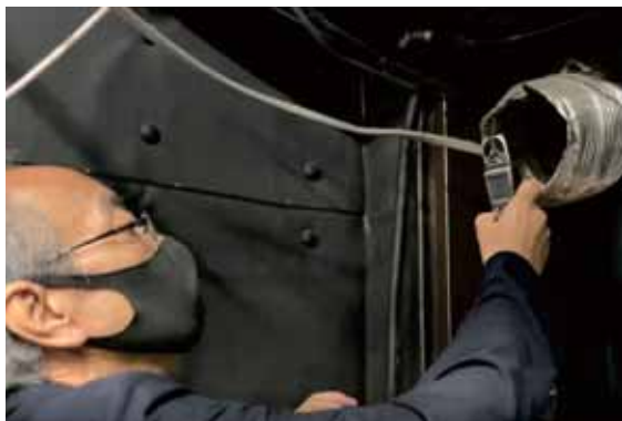
換気扇つなぎこみ →風量を確認
